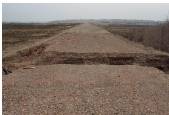
Рисунок 8.21 – Разрушение земляного полотна у трубы
