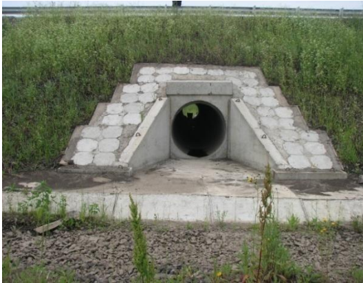
Рисунок 8.22 – Укрепление выходного русла комбинированного типа; 1 – бетонная плита; 2 – каменная наброска в ковше размыва; 3 – предохранительный откос; h_{отк} – глубина заложения предохранительного откоса; h_{разм} – глубина ямы размыва
