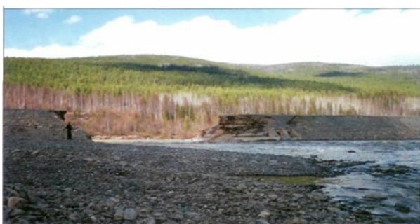
Рисунок 8.4 – Разрушение фильтрующей насыпи
