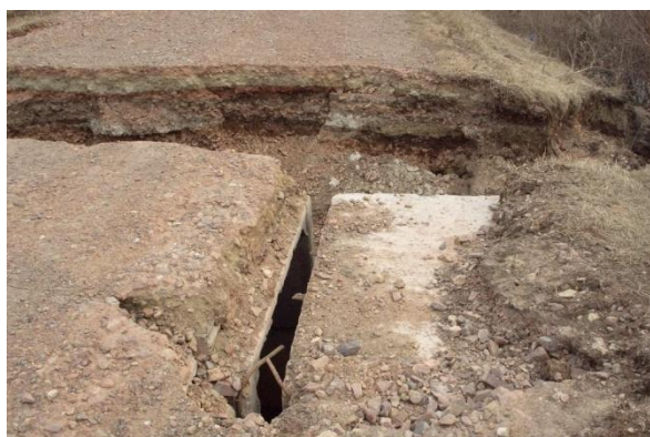
Рисунок 8.21 – Разрушение земляного полотна у трубы
