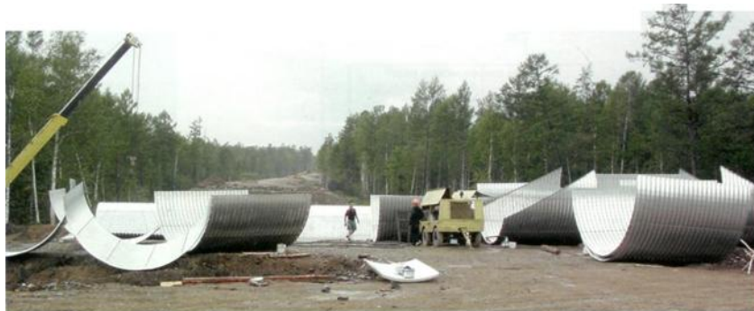
Рисунок 8.2 – Сборка гофрированной трубы
